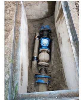
Compteur général distribution sortie réservoir
